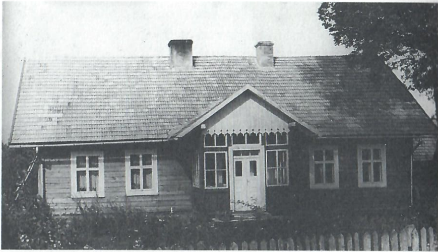
Budynek leśniczówki wzniesiony w 1879 r. – po kolejnym remoncie. Szegdy, lata 60. XX w.
