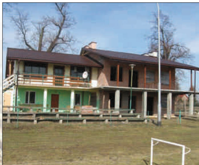
Budynek szatni w Wiązownicy.
